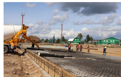
Строительство деревоперерабатывающего завода в Бабаевском округе
