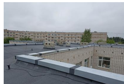
Ремонт кровли МБДОУ «Детский сад № 2 ов»
