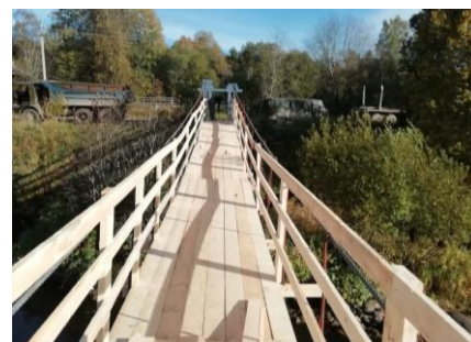
Ремонт пешеходного моста в д. Морозово Бабаевского округа
