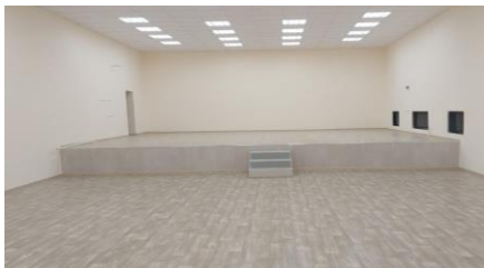
Капитальный ремонт в Пяжелском ДК
