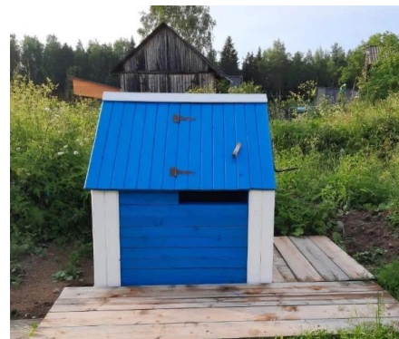
Новый колодец в пос. Пяжелка
