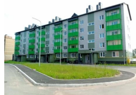
Новый 60-квартирный жилой дом
