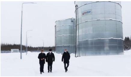
Станция обезжелезивания г.Бабаево
