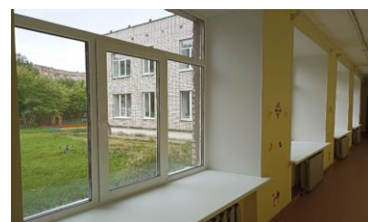
Ремонт МБДОУ «Детский сад № 2 ов»
