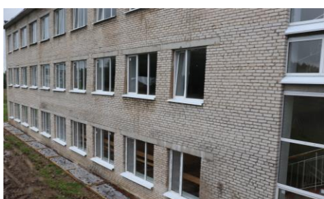
Ремонт в МБОУ «Борисовская сош»
